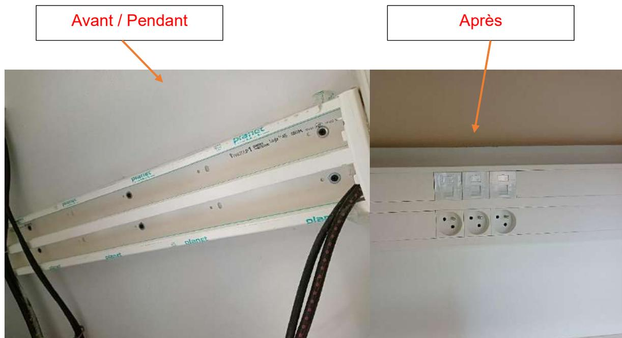
Au total, il y a six prises électriques et six prises informatiques RJ45 disposées en blocs de trois prises électriques et trois prises internet sous la table du comptoir.
