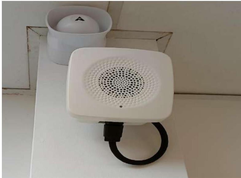
Pour poser les balises sonores, j'ai dû faire un trou dans le mur pour passer une gaine à travers laquelle j'ai tiré le câble et effectué le raccordement de mon haut-parleur.
